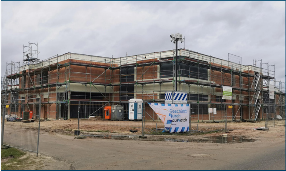
Die neue Kita auf dem Telbraker Esch ist bald fertig
