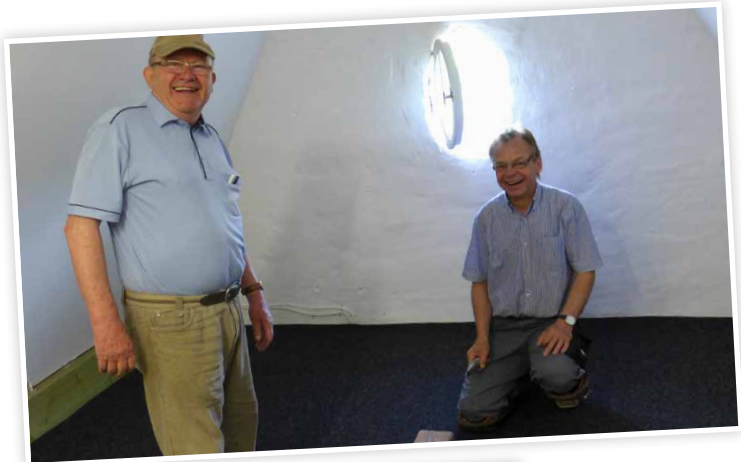
Werner Thomann und Heinz Diekmann beim Ausbau des Dachbodens
