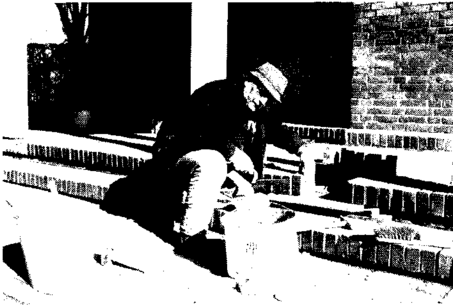
Sanierung des alten Einganges bei der Marienschule durch Paul Stukenborg
